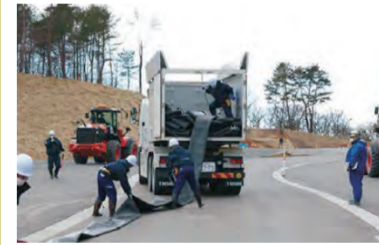
冷却水を移送するためのホース展張訓練
