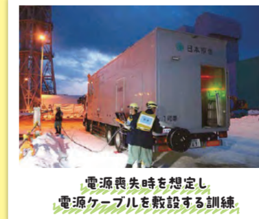
電源喪失時を想定し、電源ケーブルを敷設する訓練
